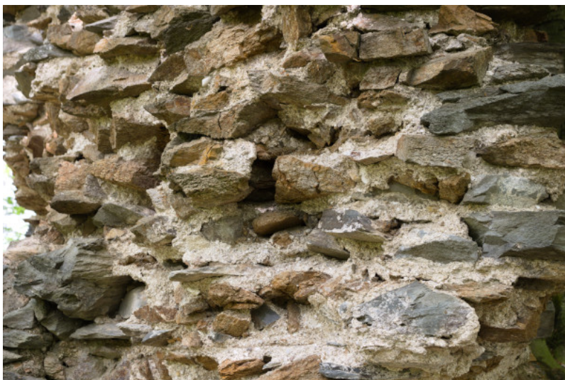
Pohled do profilu obvodové hradby – skutečná šíře 3,5 m (Roimund)
