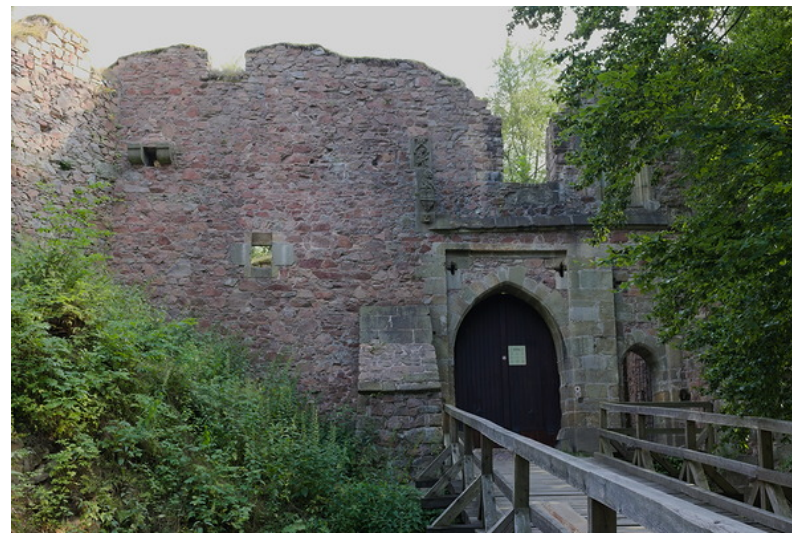
Čelo branné věže – vlašský komín, opěrák, průvlaky řetězů mostu (Litice)
