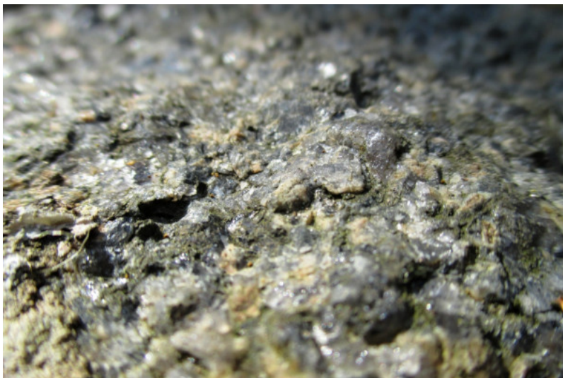
Korozivní rozpad žuly (Žihle u Plzně)
